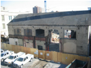
Le Coeur des sciences en restauration
